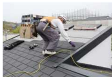
屋根の断熱化工事
